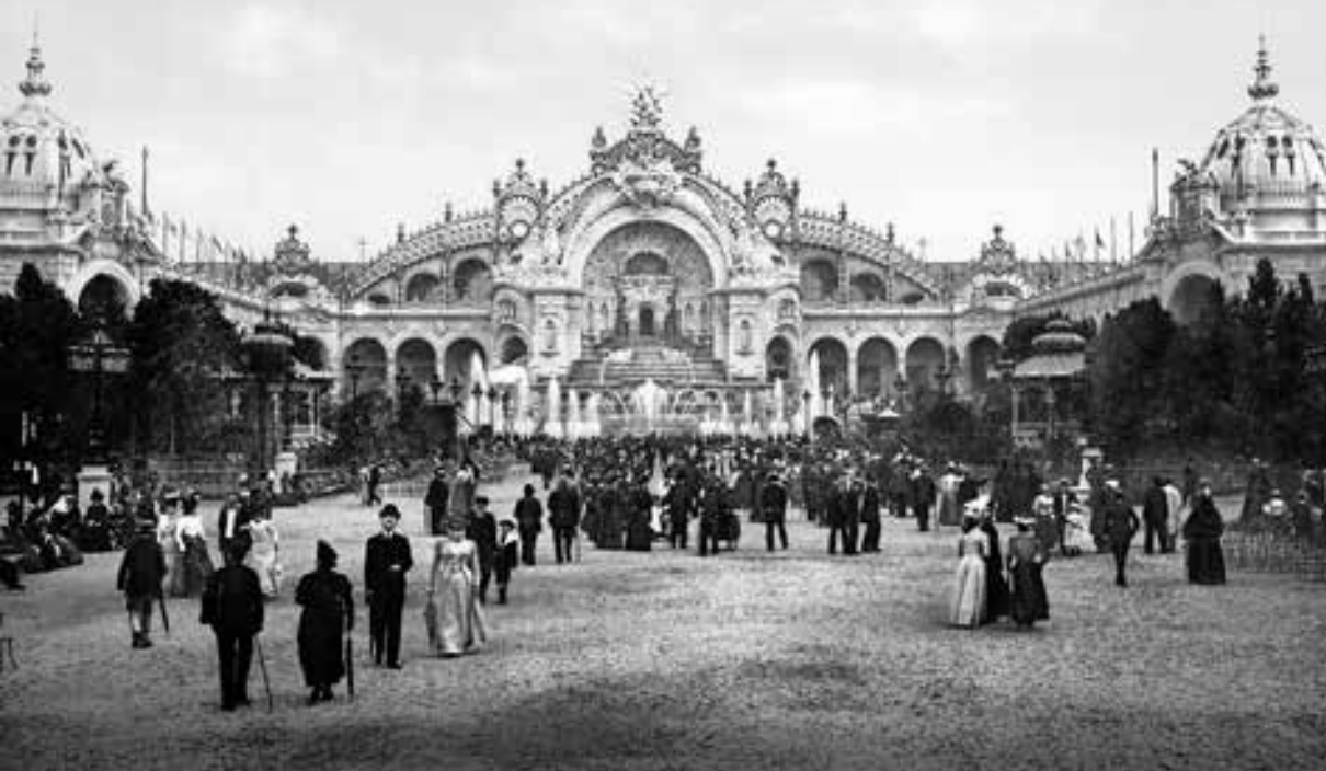
Palác elektřiny v Paříži. Budova byla, jak název napovídá, plně osvětlena elektrickým proudem.
